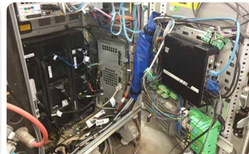
Řídicí počítač může být díky malým rozměrům a nízké hmotnosti umístěn na dvířka stávajícího rozvaděče
