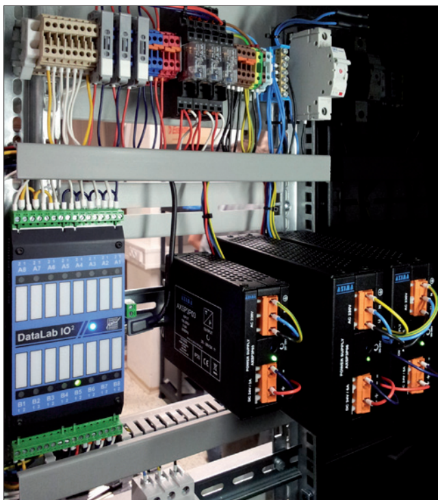
Obr. 1. Jednotka DataLab IO v rozváděči stroje připojená na systém strojového vidění
